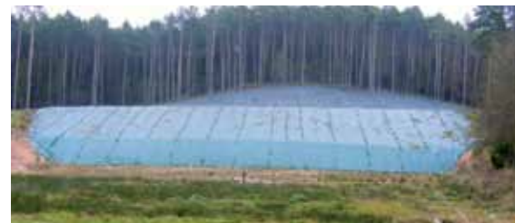
Abb.1: Beispiel flächiger Schrotfang mit Netzen, WSSA Weismain, Bayern
