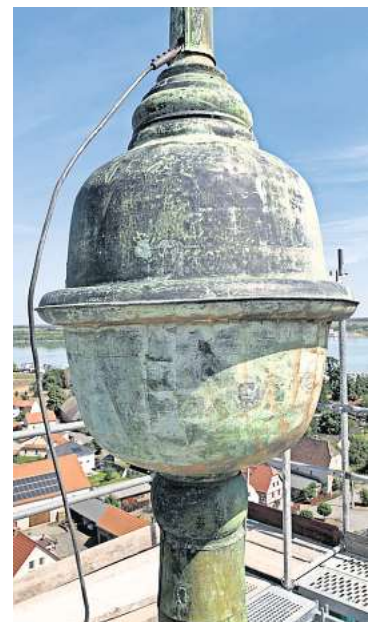
Die Kugel auf der Kirchturmspitze in Kahnsdorf ist hier noch verwittert. In wenigen Tagen werden Kugel und Wetterfahne in frischem Glanz auf den Turm gesetzt.
