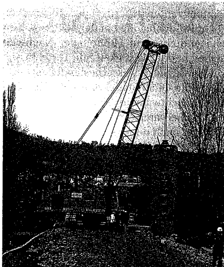
Bild 2: Herstellung der Einphasendichtwand mithilfe eines Schlitzwandgreifers
