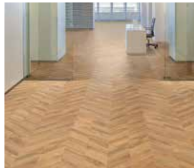
4111 – Verlegung mit je zwei gegenläufigen Planken
